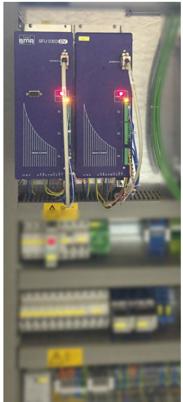
Der Frequenzumrichter SFU0303 ist speziell für moderne Bearbeitungszentren konzipiert. (Bilder: BMR)
